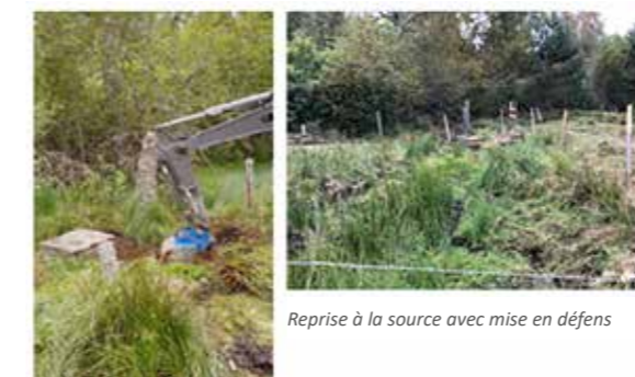
Travaux Haut Allier ©Anne Rémond, CEN Occitanie
