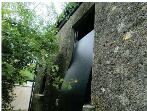
Fenêtre aménagée pour l'accès des petits rhinolophes, tout en évitant l'intrusion de carnivores, grâce à la plaque métallique sous-jacente.
