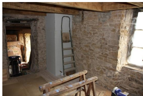
à droite: colonne d'accès traversant le premier étage
