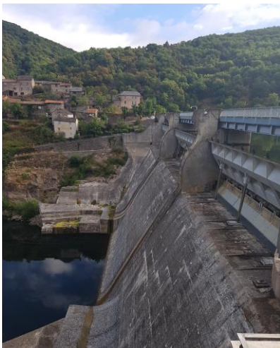
Barrage du Pinet sur le Tarn (12) © J. Robin
