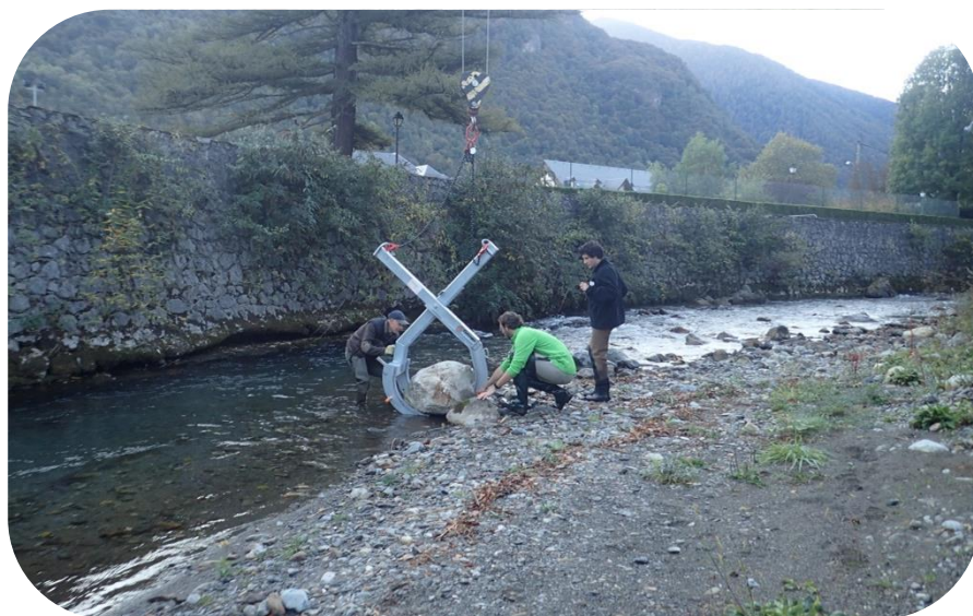
Figure 17 : Travaux de diversification d'habitats sur la Pique ©Melody Lim (CEN Occitanie)
