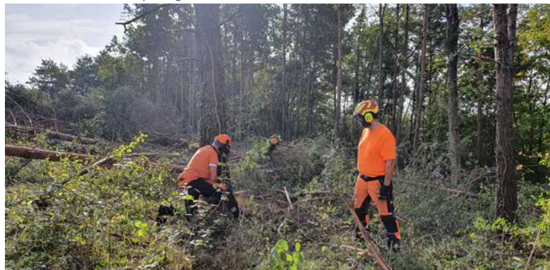
Chantier avec un lycée agricole en Haute-Garonne ©Mathilde Cassé CEN Occitanie
