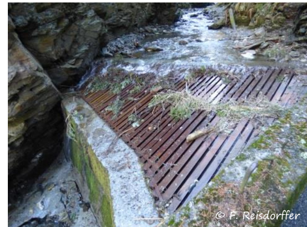
Prise d'eau constituant un seuil
