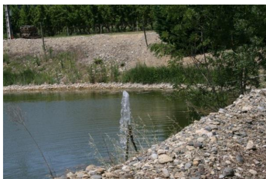
La retenue d'eau contiguë à la roselière (fonction d'irrigation du centre expérimental de Syngenta, avec un pompage quasi-permanent en période estivale de la nappe d'accompagnement)
