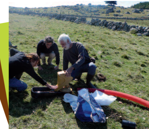
Mise en place d'une pompe à museau sur l'Aubrac
